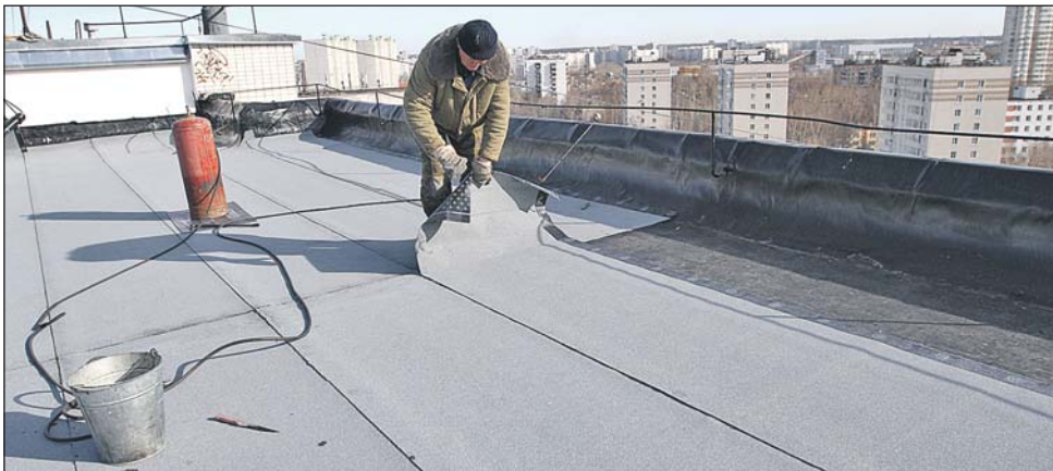
Выборочный капитальный ремонт (Ясный проезд, 156)
